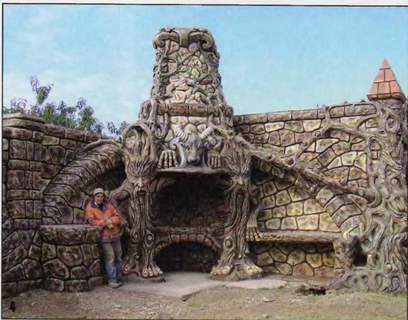
Топка этого садового очага сделана из бетона без футеровки. Такие топki выдерживают длительную (более 20 лет) эксплуатацию без признаков разрушения. Андрей — постоянный член нашей команды.
