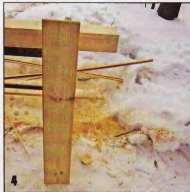
Из остатков тонких половых досок изготовили полую декоративную балку (короб).
