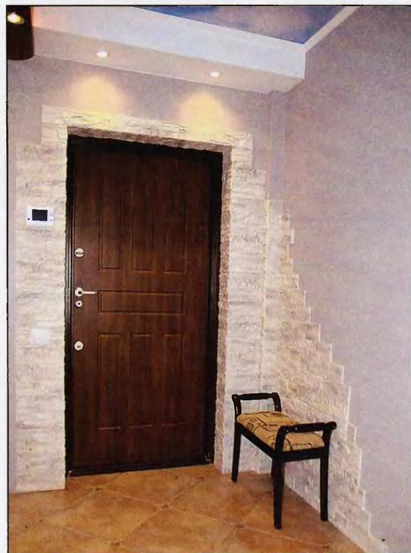
Балка над входной дверью закрыта коробом с вмонтированными в него точечными светильниками.
