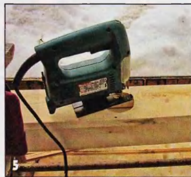
Электролобзиком пропилили отверстия под светильники.
