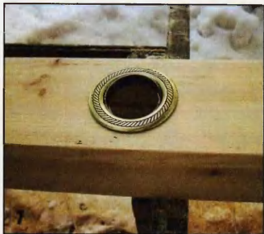
Поочерёдно установили светильники в отверстия короба.
